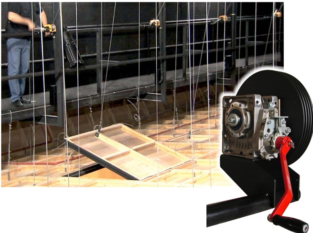
Al igual que en los cortes contrapesados, los cortes de torno mural tienen la función de manipular decorados y barras electrificadas de considerable peso para poder ser manipuladas de forma manual.
